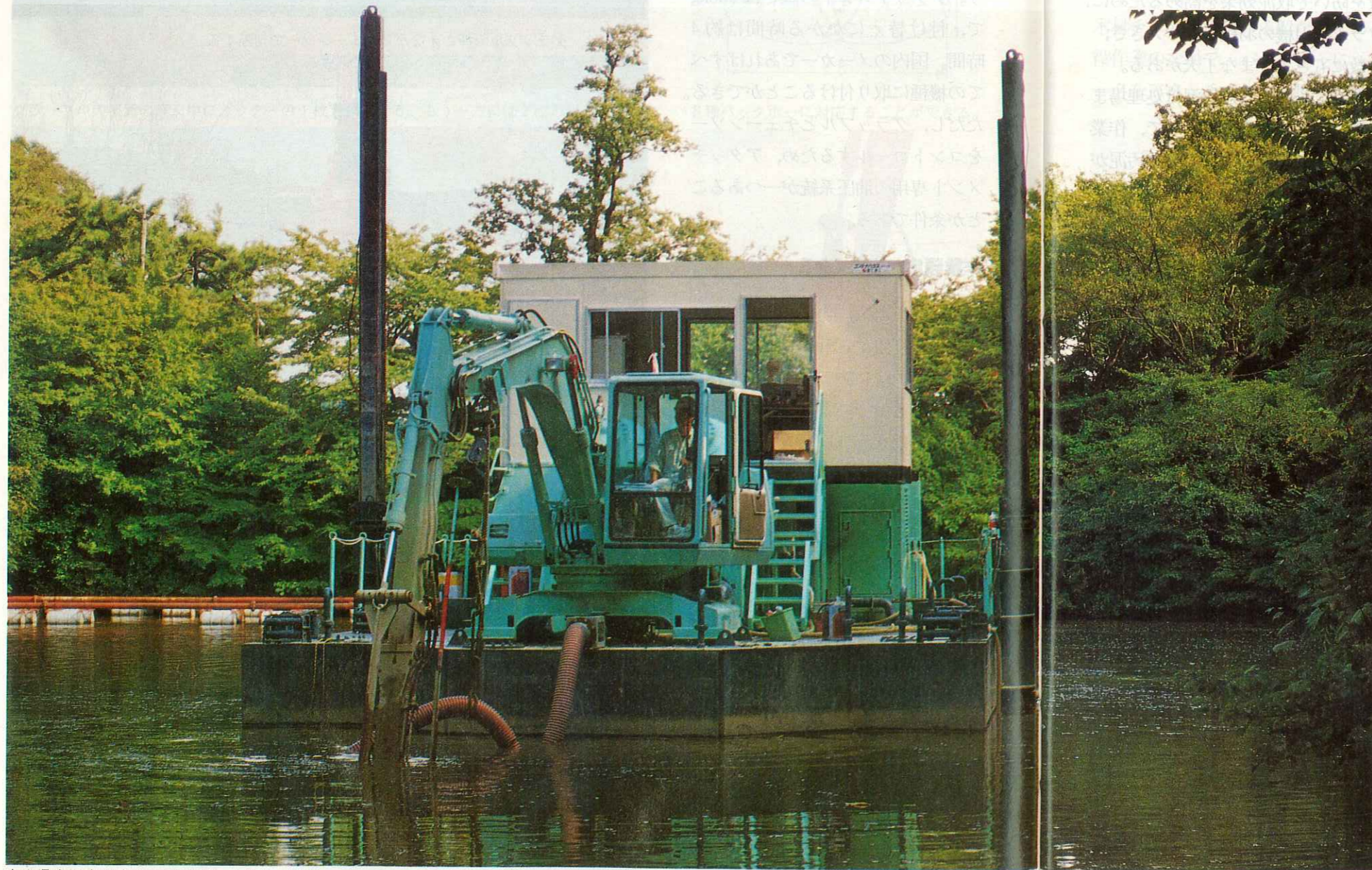
富山県高岡市の古城公園でのしゅんせつ工事。バックホーの先に取り付けたドラム吸引機でしゅんせつする（この項の写真：早水組）
